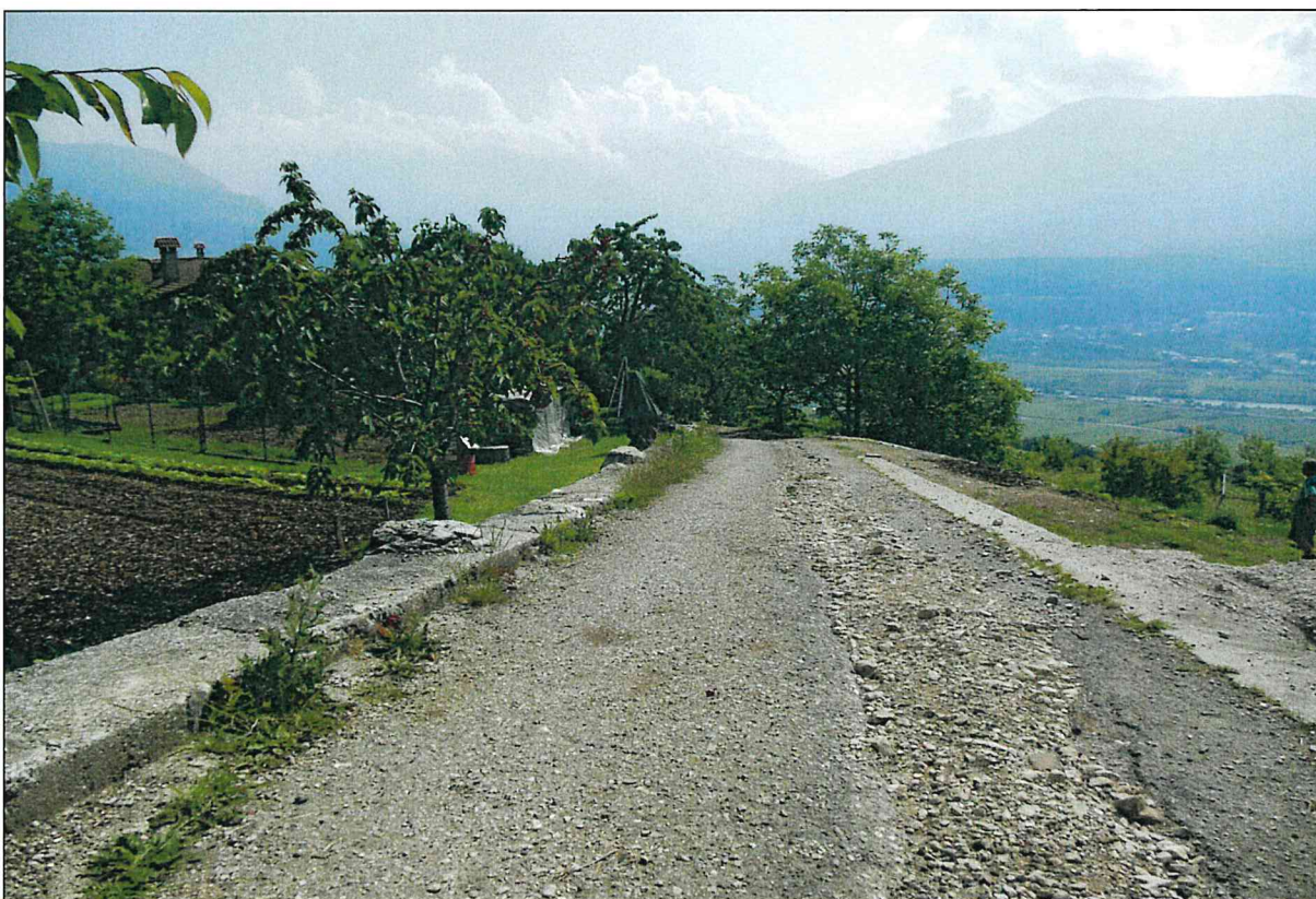
via Belvedere: tratto intermedio
