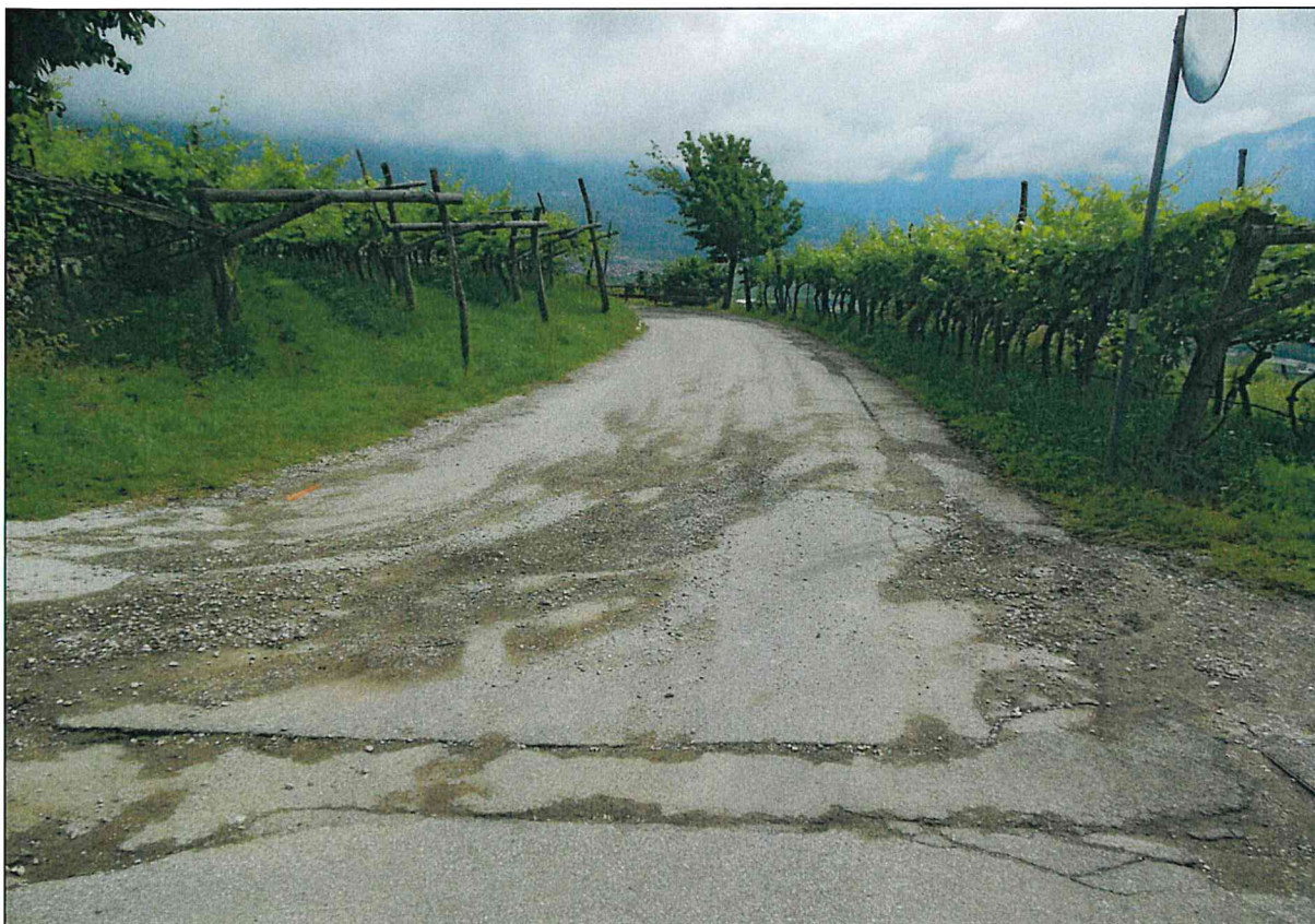
via Belvedere: tratto strada comunale Noarna-Patone
