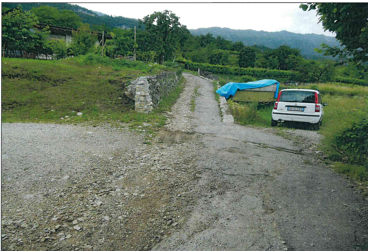
via Erta dei Friuli: tratto antistante entrata edifici residenziali "F.Ili Pizzini"
