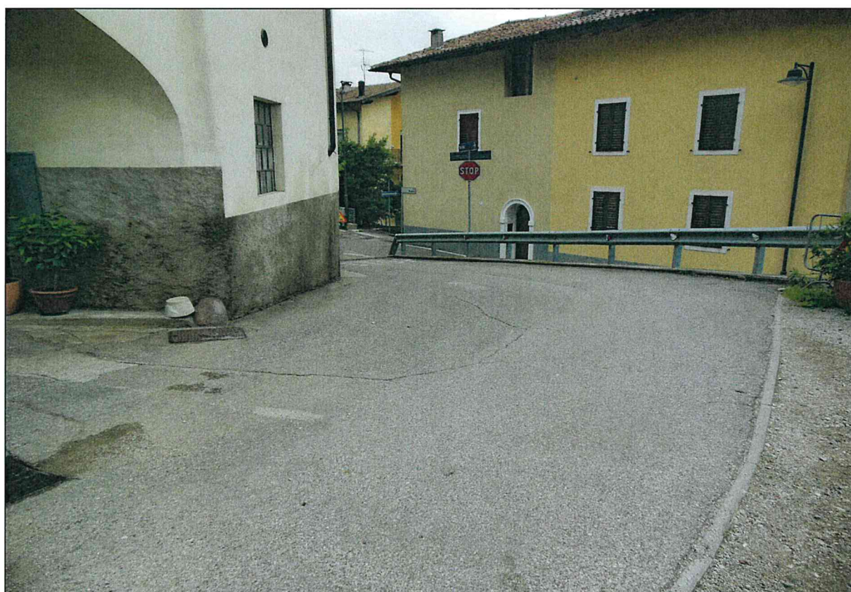
via Belvedere: tratto strada comunale Noarna-Patone
