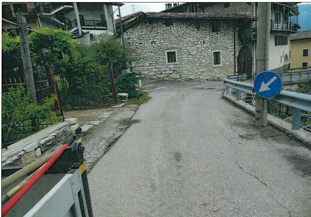
via Belvedere: tratto strada comunale Noarna-Patone
