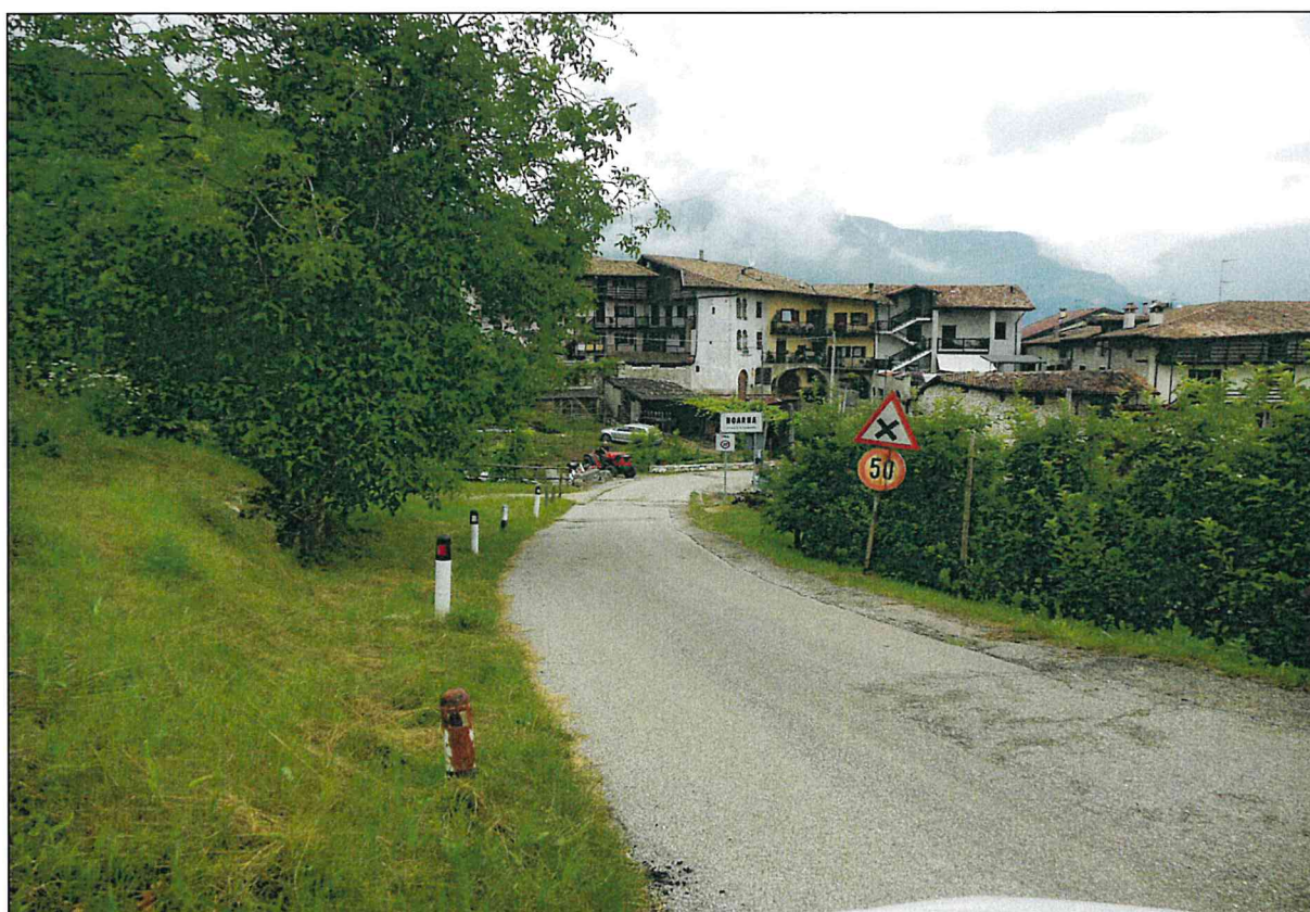
via Belvedere: tratto strada comunale Noarna-Patone
