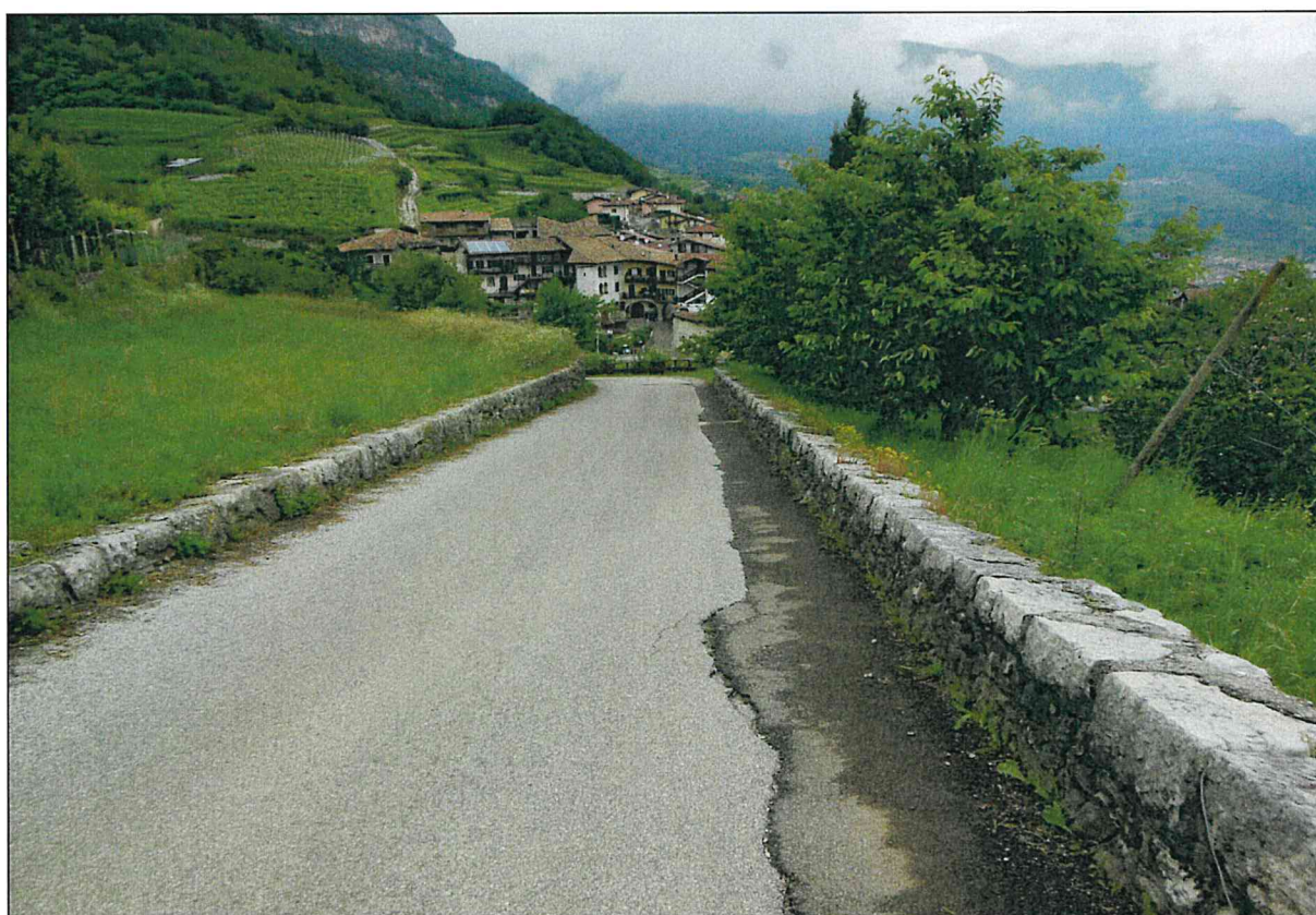
via Belvedere: tratto strada comunale Noarna-Patone
