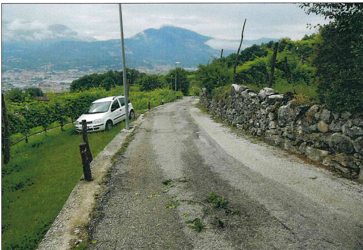
via Belvedere: tratto intermedio
