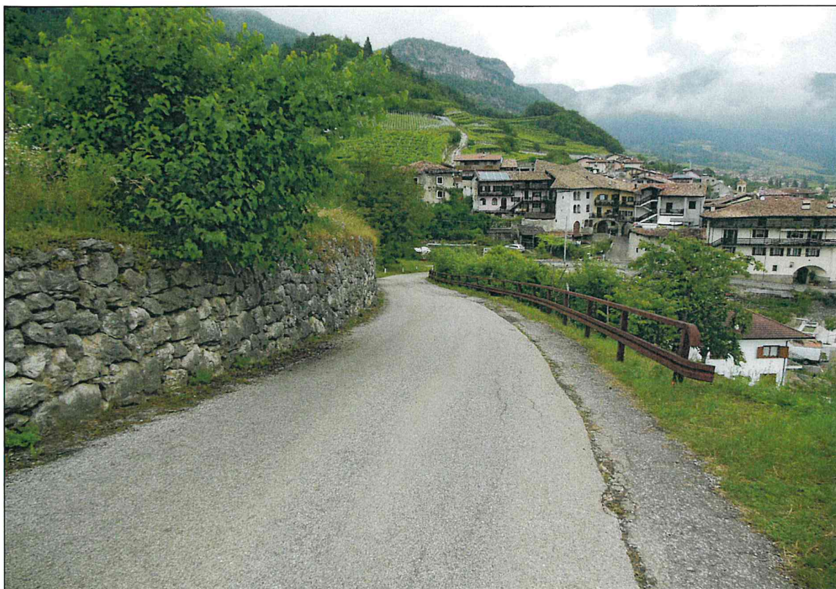
via Belvedere: tratto strada comunale Noarna-Patone
