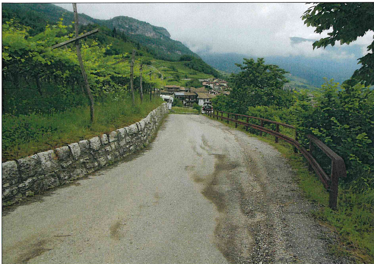
via Belvedere: tratto strada comunale Noarna-Patone
