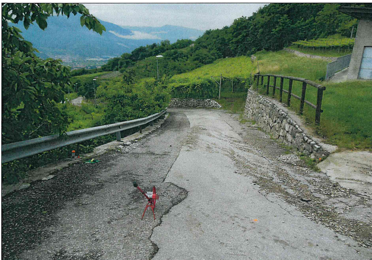
via Belvedere: tratto antistante edificio tecnico C.M.F.
