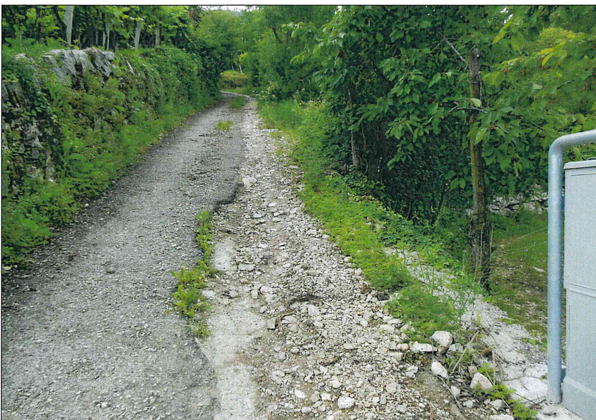
via Erta dei Friuli: tratto intermedio a seguire II a zona cementata
