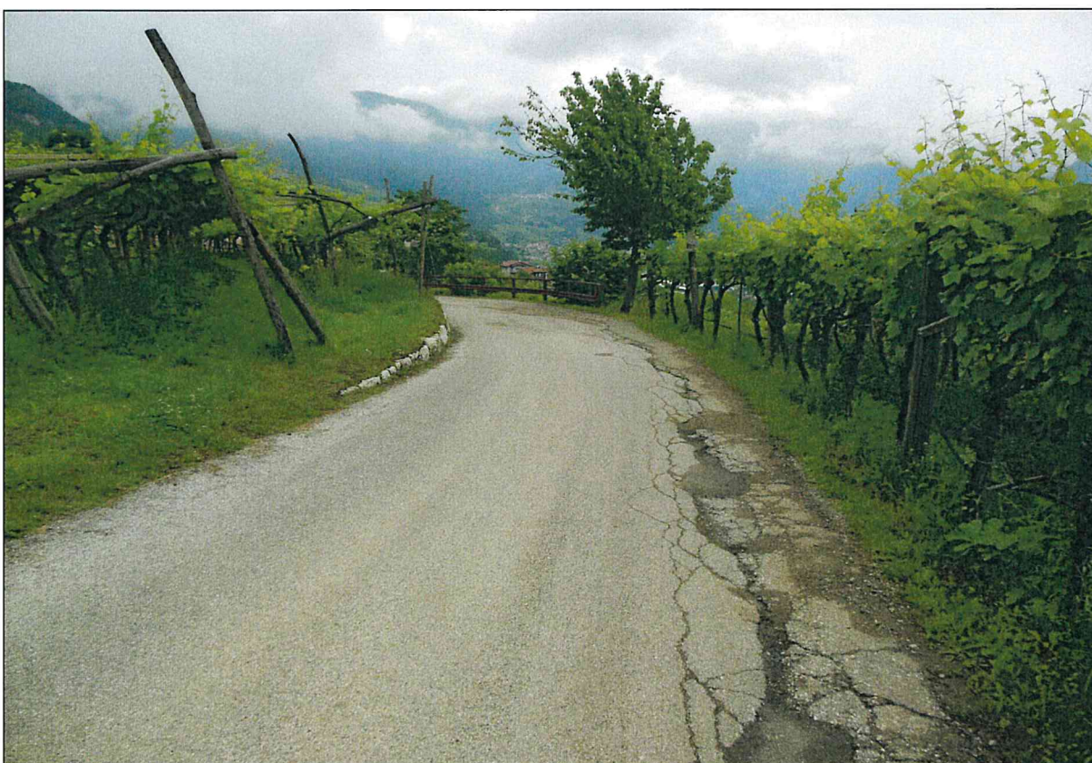
via Belvedere: tratto strada comunale Noarna-Patone
